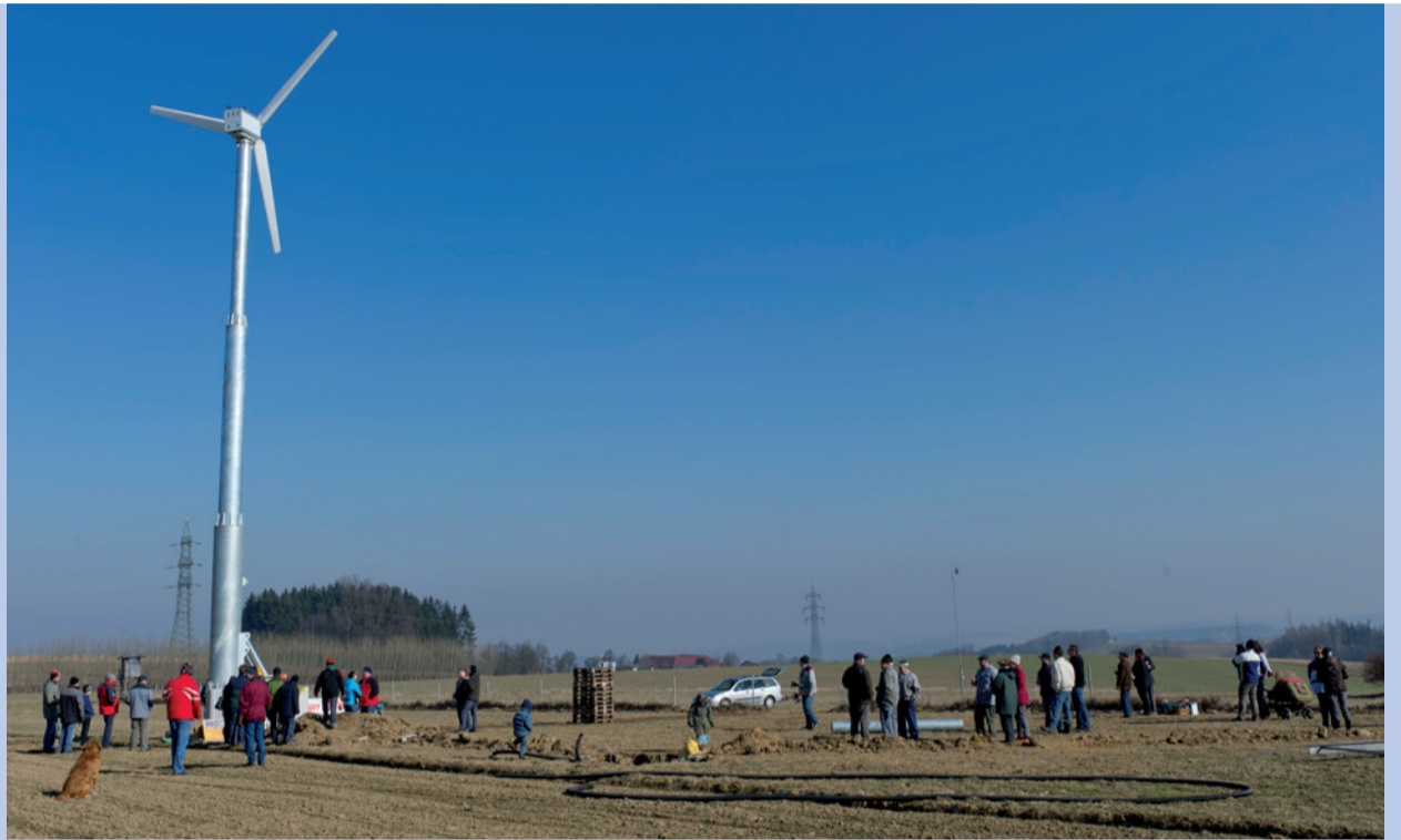
Zur Genehmigungsfähigkeit einer Windenergieanlage gehört im Rahmen der Erschließung des Geländes die sog. Zuwegung.
